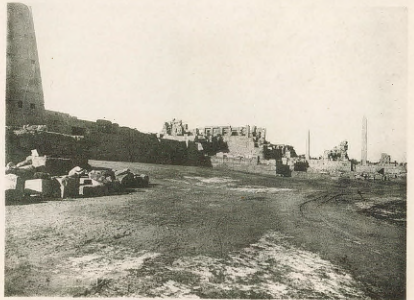
Les travaux à l'Ouest du Lac Sacré, pendant et après les déblaiements.
